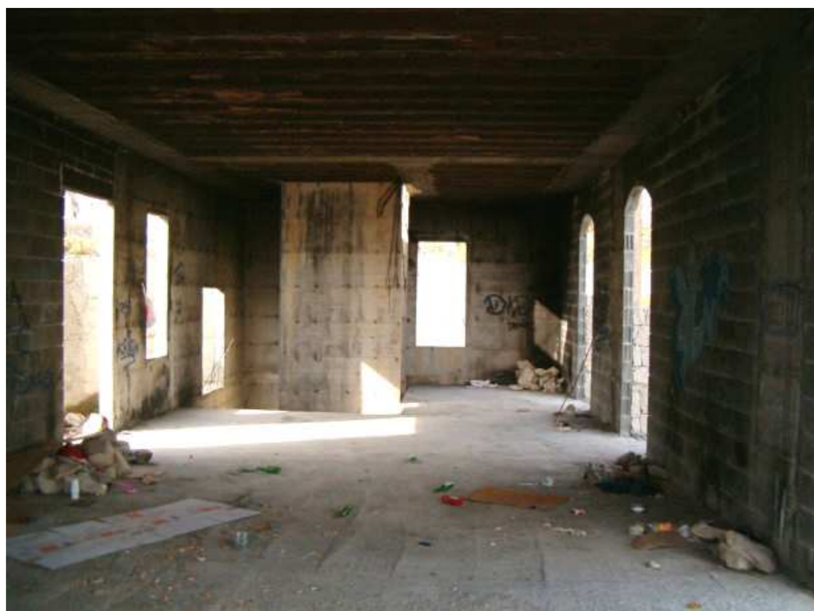
VISTA DALL'INTERNO, PIANO PRIMO VERSO NORD
