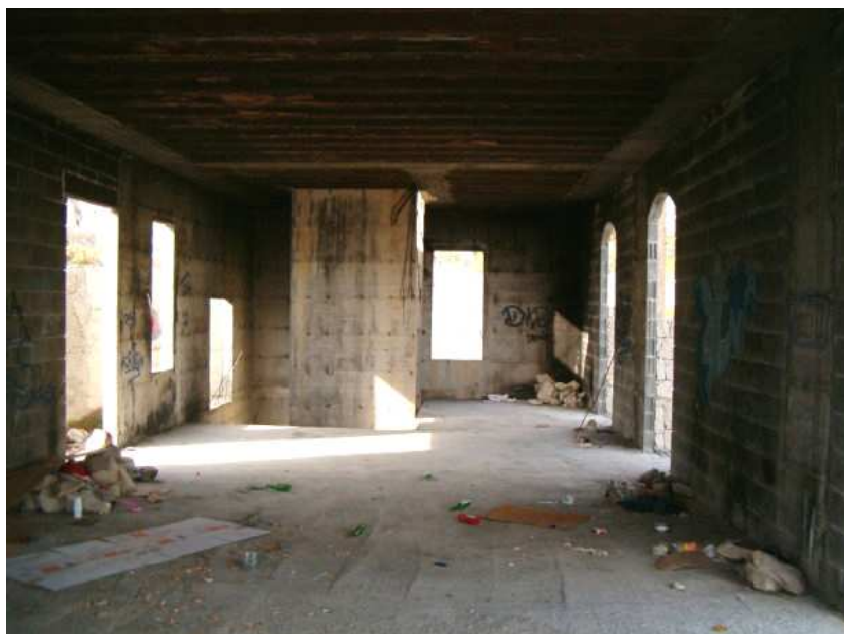
VISTA DALL'INTERNO, PIANO PRIMO VERSO NORD
